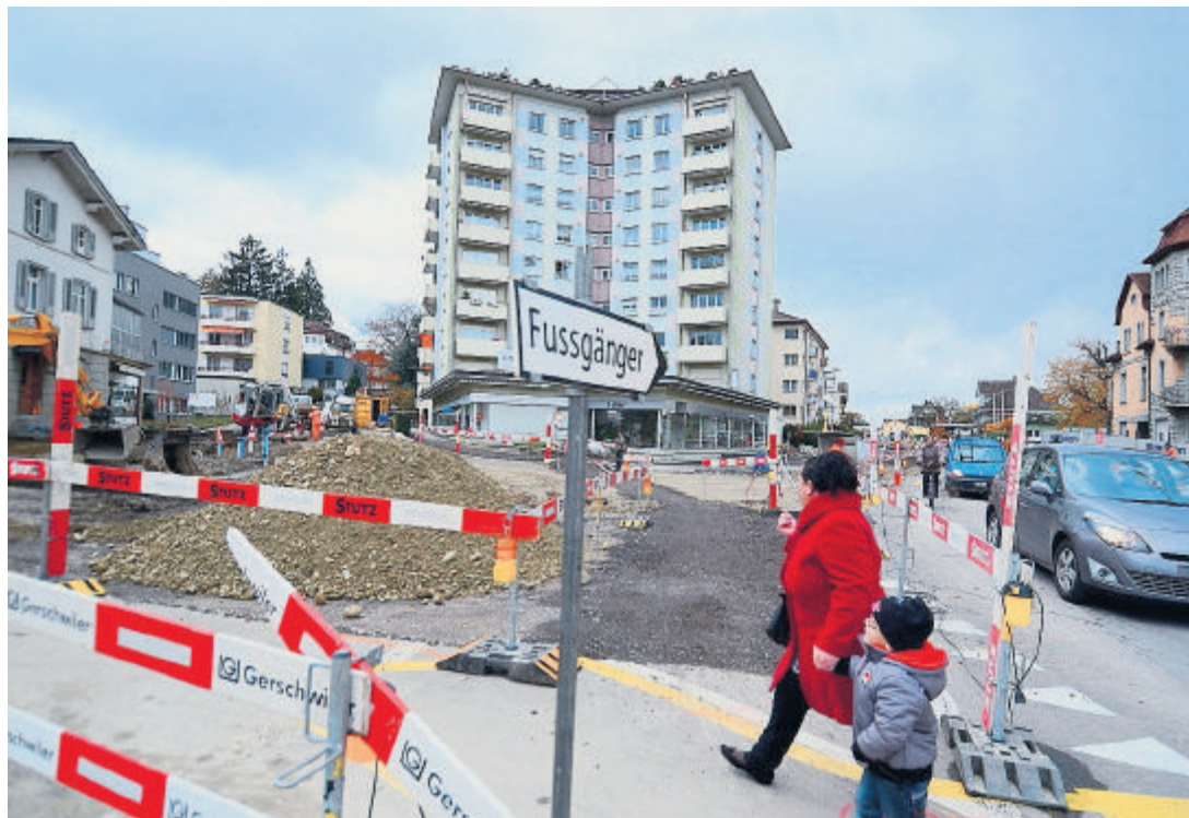
Fussweg über die Baustelle, unterbrochene Strassen, Staus: Leitungssalat erschwert die Bauarbeiten.
